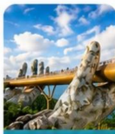
สะพานมือสีทอง
